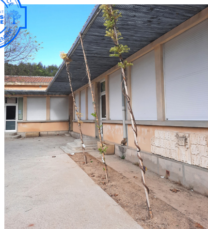
Des glycines (plantes grimpantes) ont été plantées aux pieds des caillebotis, afin de végétaliser ces petits préaux, situés devant les salles de classe. ▶
