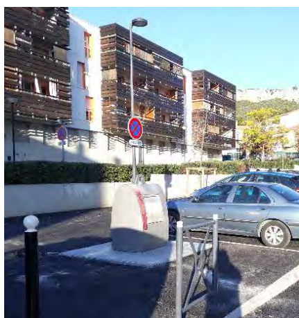
Dispositif enterrés sur la commune de Vitrolles
