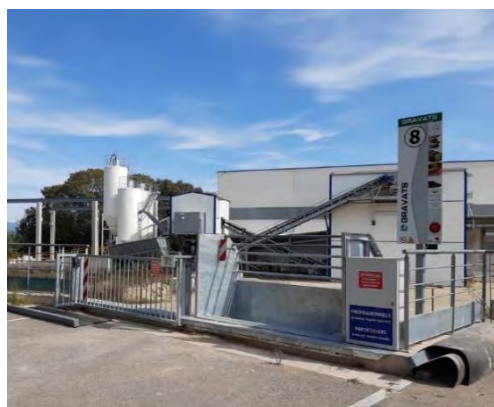
Quai pour les gravats Déchèterie de La Roque d'Anthéron
