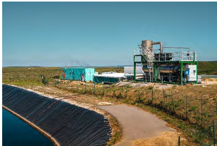
Station de traitement des lixiviats
