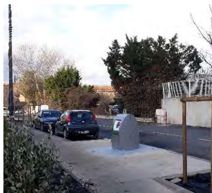
Dispositif enterré sur la commune de Trets
