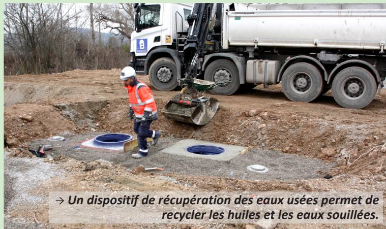
→ Un dispositif de récupération des eaux usées permet de recycler les huiles et les eaux souillées.
