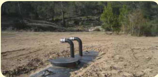
Le Grand Site Sainte-Victoire a procédé à la mise en place d'une citerne enterrée d'une capacité de 80 000 litres d'eau à proximité directe de la piste DFCI 106 (carrefour de Jalai), et en a assuré la totalité du financement. Cette installation permettra de renforcer les moyens en eau nécessaires à la lutte contre les incendies de forêt.
